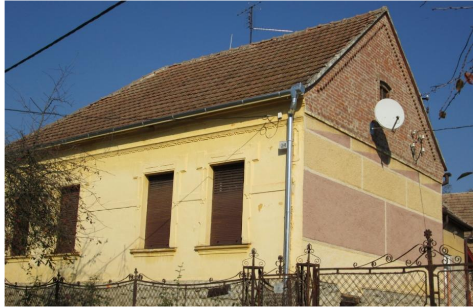
Kossuth Lajos utca 24. (Eredeti formáját megtartva felújított.)
