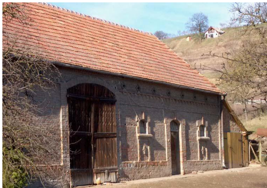
Kossuth L. u. 7 szám, 25 hrsz. A nyeregtetős, oromfalas épület udvari homlokzatát mértéktartó téglarchitektúrával kialakított tagozati elemek osztják, faragott fa kapuja és padlásszellőző nyílásai díszítik.
