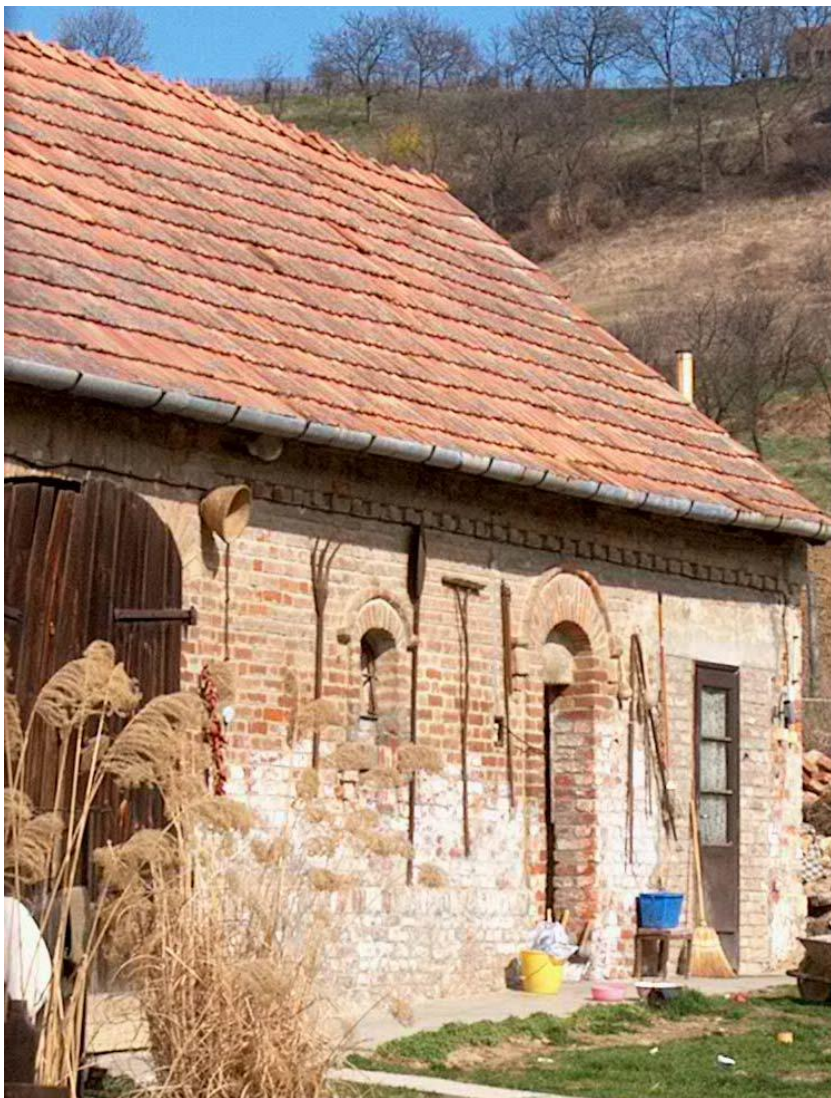
Kossuth L. u. 12 szám, 29 hrsz. A nyeregtetős, oromfalas gazdasági épület eredeti formáját őrzi. A nyílásosztást kiemelő, falsíkot díszítő tagozatokkal megtört természetes anyaghasználattal kialakított épület
