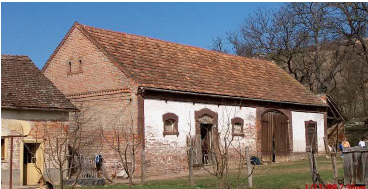
Kossuth L. u. 4 szám, 22 hrsz. A lakóház mögött oldalhatáron álló, tömegével kiemelkedő, nyeregtetős, oromfalas gazdasági épület, tégladíszítéssel és színeképzéssel kialakított eredeti homlokzati megjelenésével.
