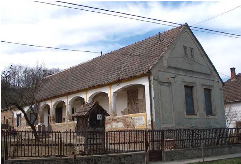
Dózsa Gy. u. 9 szám, 109 hrsz. Az utcára merőleges gerincű, nyeregtetős, oromfalas lakóépület eredeti kubusát őrzi. A hagyományos egytraktusos épület udvari homlokzata mellvédes, falazott oszloppilléres, szegmensíves „valódi” tornácos kialakítású.
